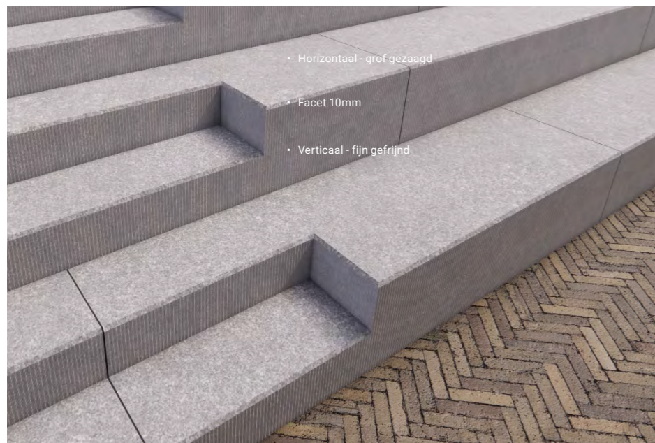
Principe materiaalafwerking: Horizontaal - grof gezaagd en Verticaal - fijn gefrijnd
