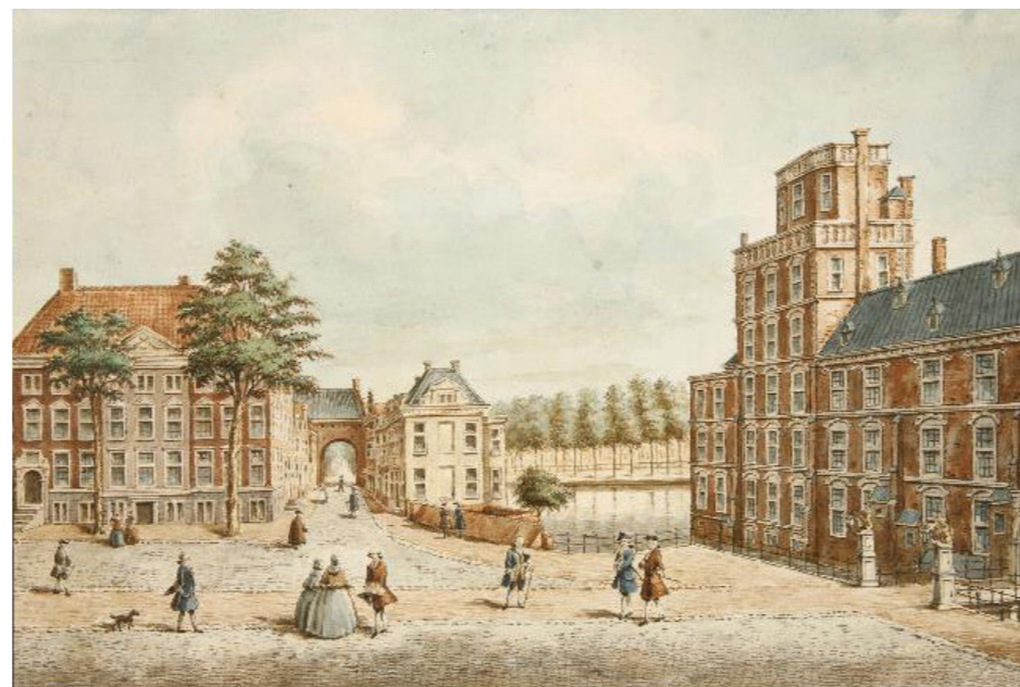
Hofgracht aan Buitenhofzijde 1770
