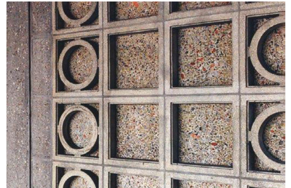
Station Hengelo - Hermanus Schelling Beton elementen met een aggregaat van baksteen
